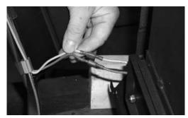
Connect the fan wires.
